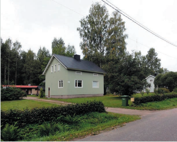
Sulkutien jälleerakennusajan taloja
